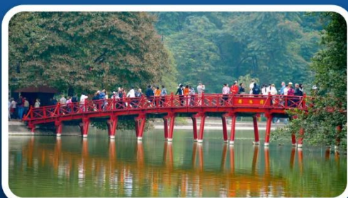
สะพานแสงอาทิตย์
