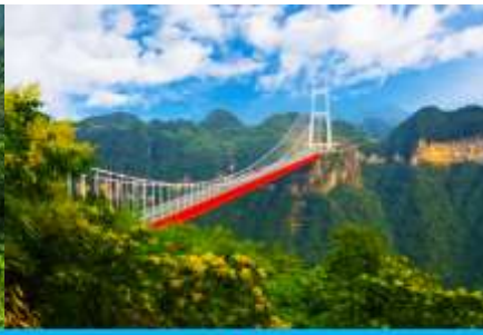
สะพาน ไร่จ้ายต้าเจียว
